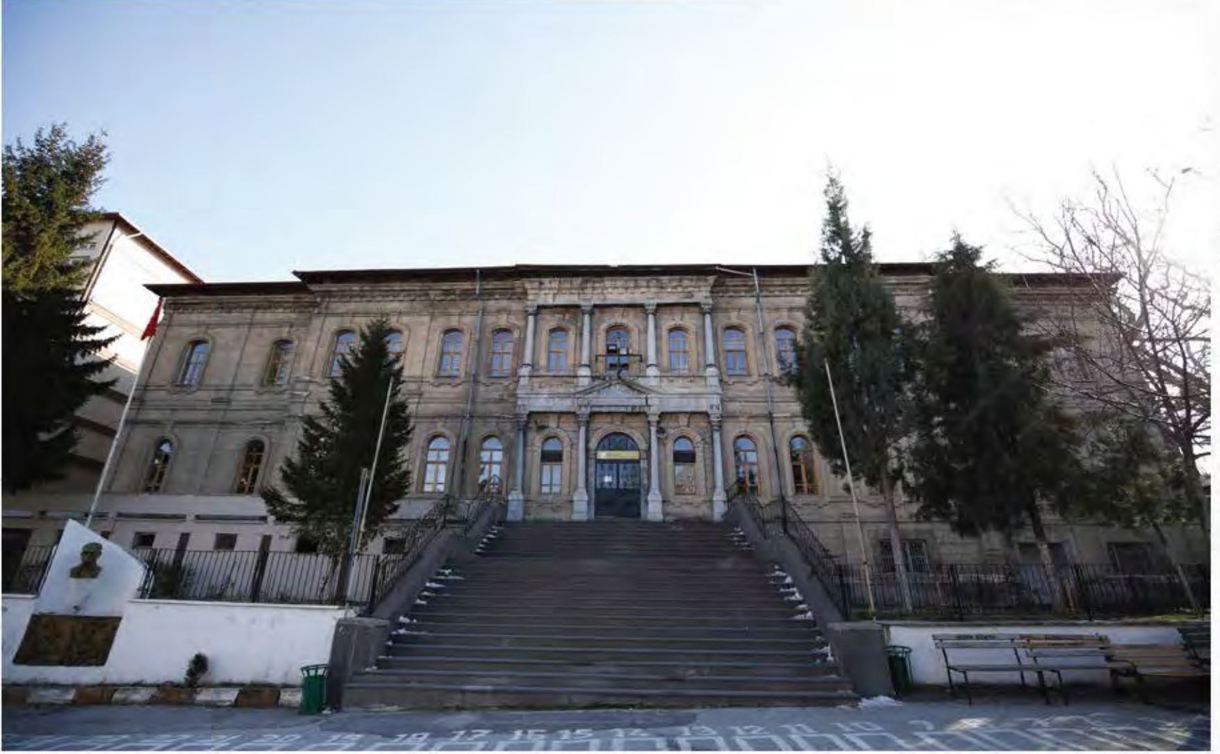
Kütahya Beylerbeyi Meslekî ve Teknik Anadolu Lisesinin Dışardan Görünüşü
