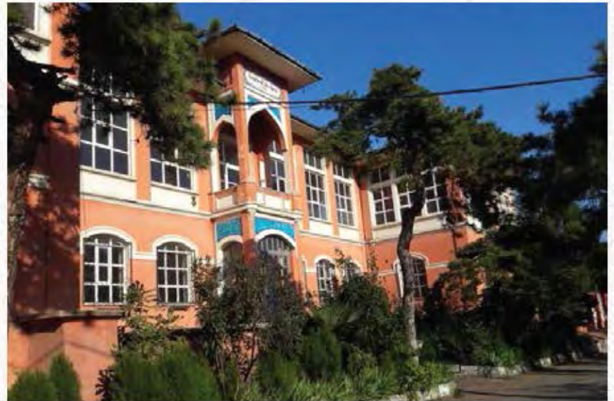
Zonguldak Meslekî ve Teknik Anadolu Lisesinin Dışardan Görünüşü
