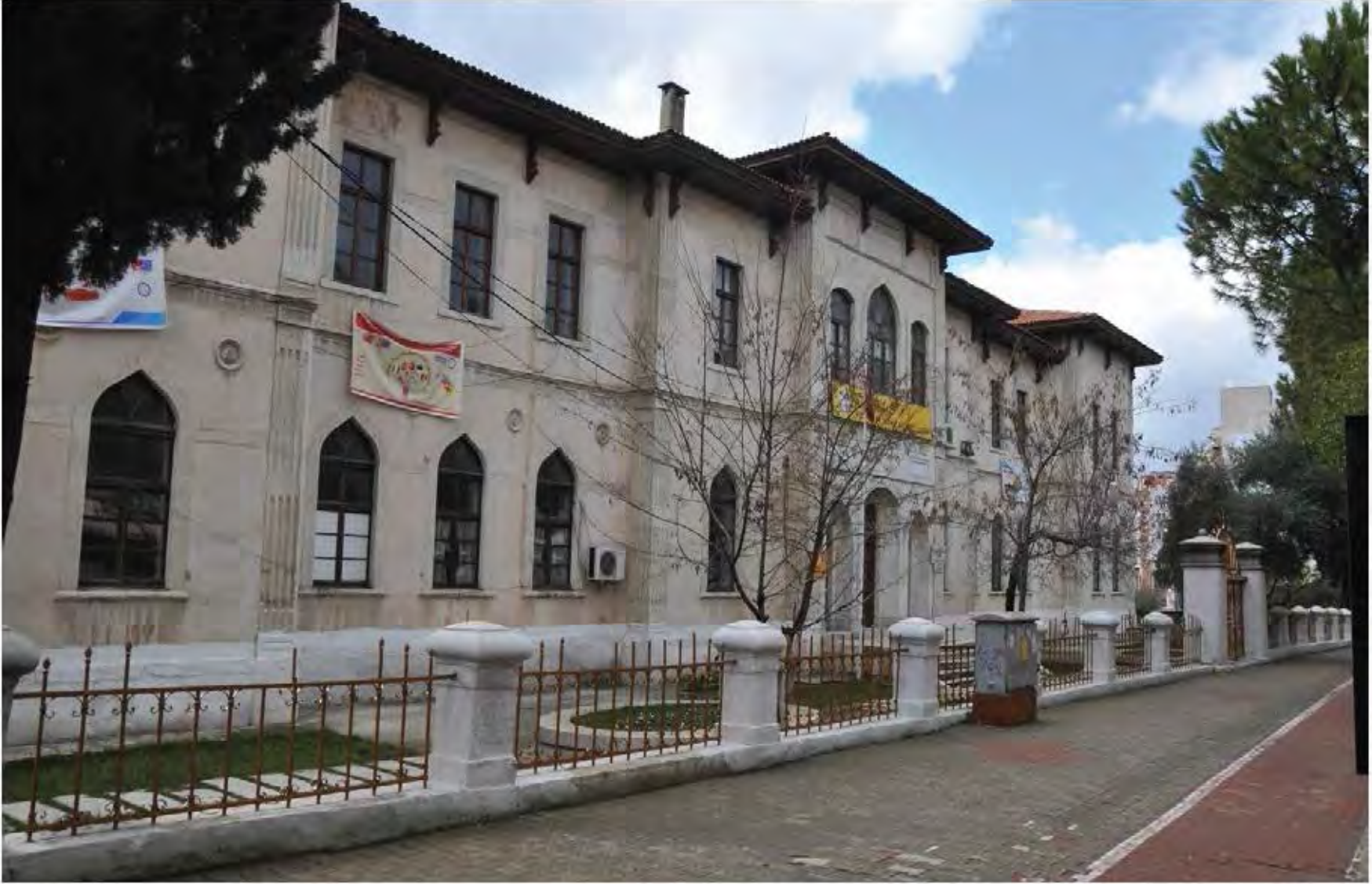
Zübeyde Hanım Meslekî ve Teknik Anadolu Lisesinin Dışından Görünüşü
